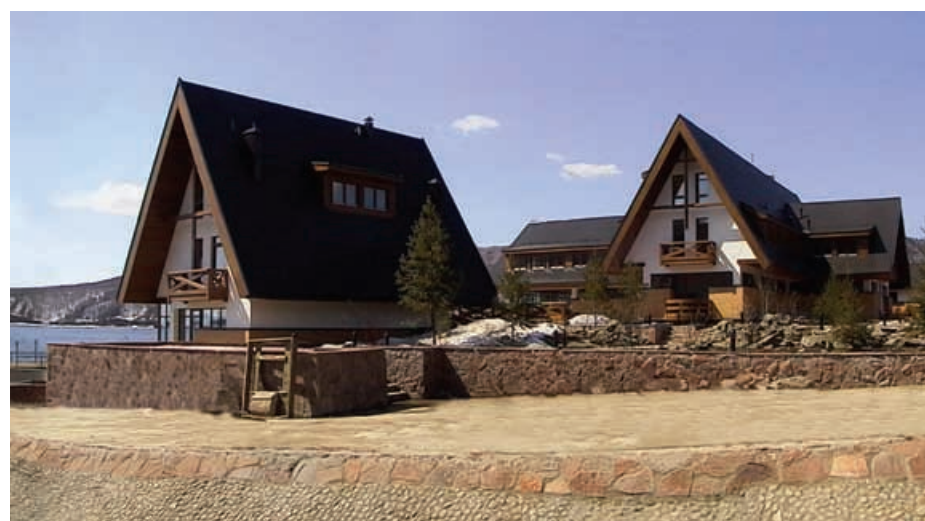
2001. Турбаза «Анастасия», пос. Никола Разработчик: ООО «Архитектурная фирма Жуковского Н.Л.» Автор: Жуковский Н.Л.
