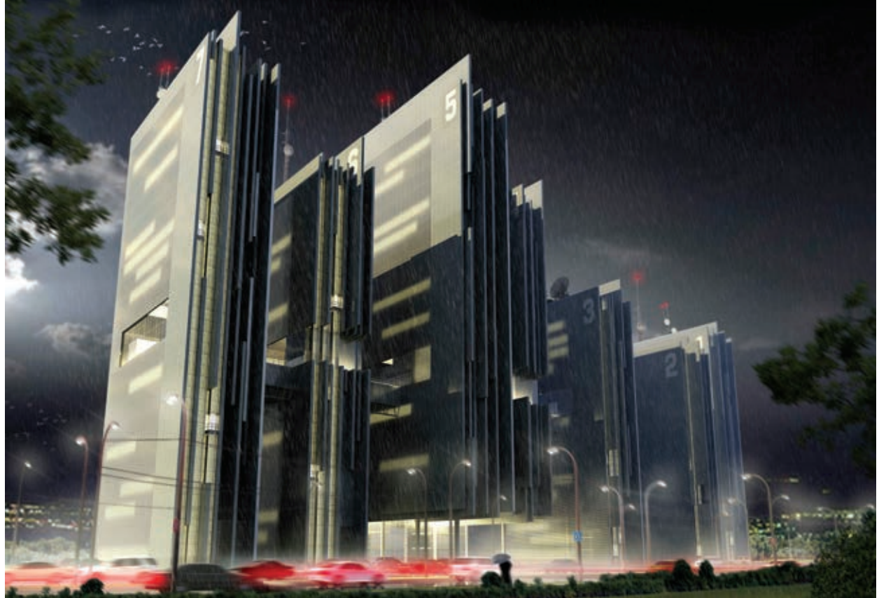
Офисное здание на ул. Поклонная
