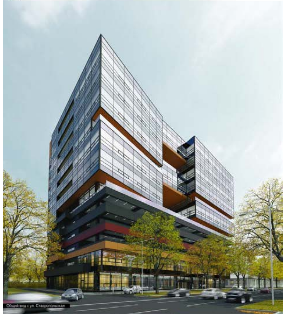
Административное здание, ул. Ставропольская, г. Краснодар. 2011 г. Заказчик ООО «БАУИНВЕСТ»
