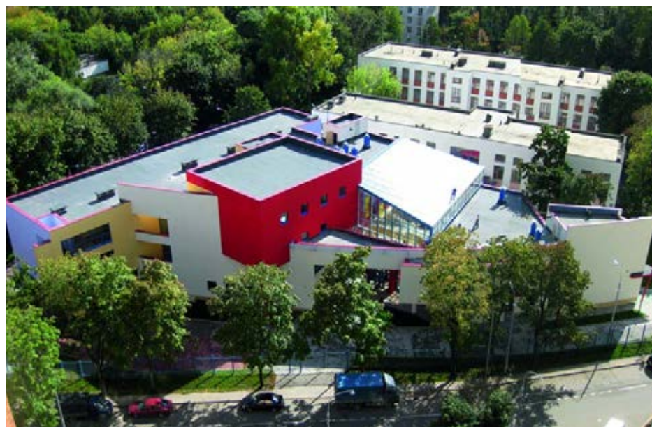
Учебный корпус школы № 274 (г. Москва, СВАО, Северное Медведково, ул. Тихомирова, д. 6)
