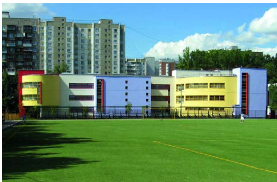
Учебный корпус школы № 290 (г. Москва, СВАО, Северное Медведково, ул. Грекова, д. 11 б)
