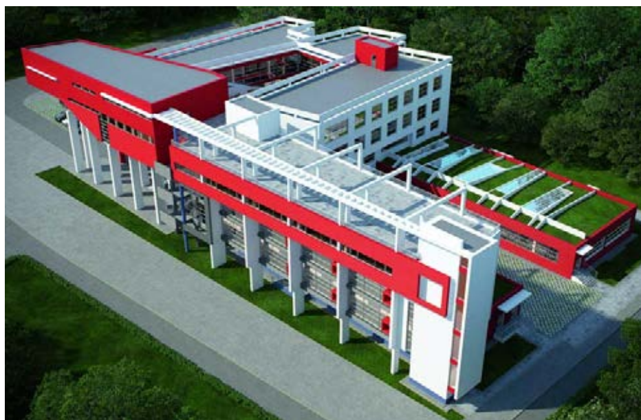
Проект здания московского колледжа художественных ремесел (г. Москва, САО, ул. Вятская, д. 37)
