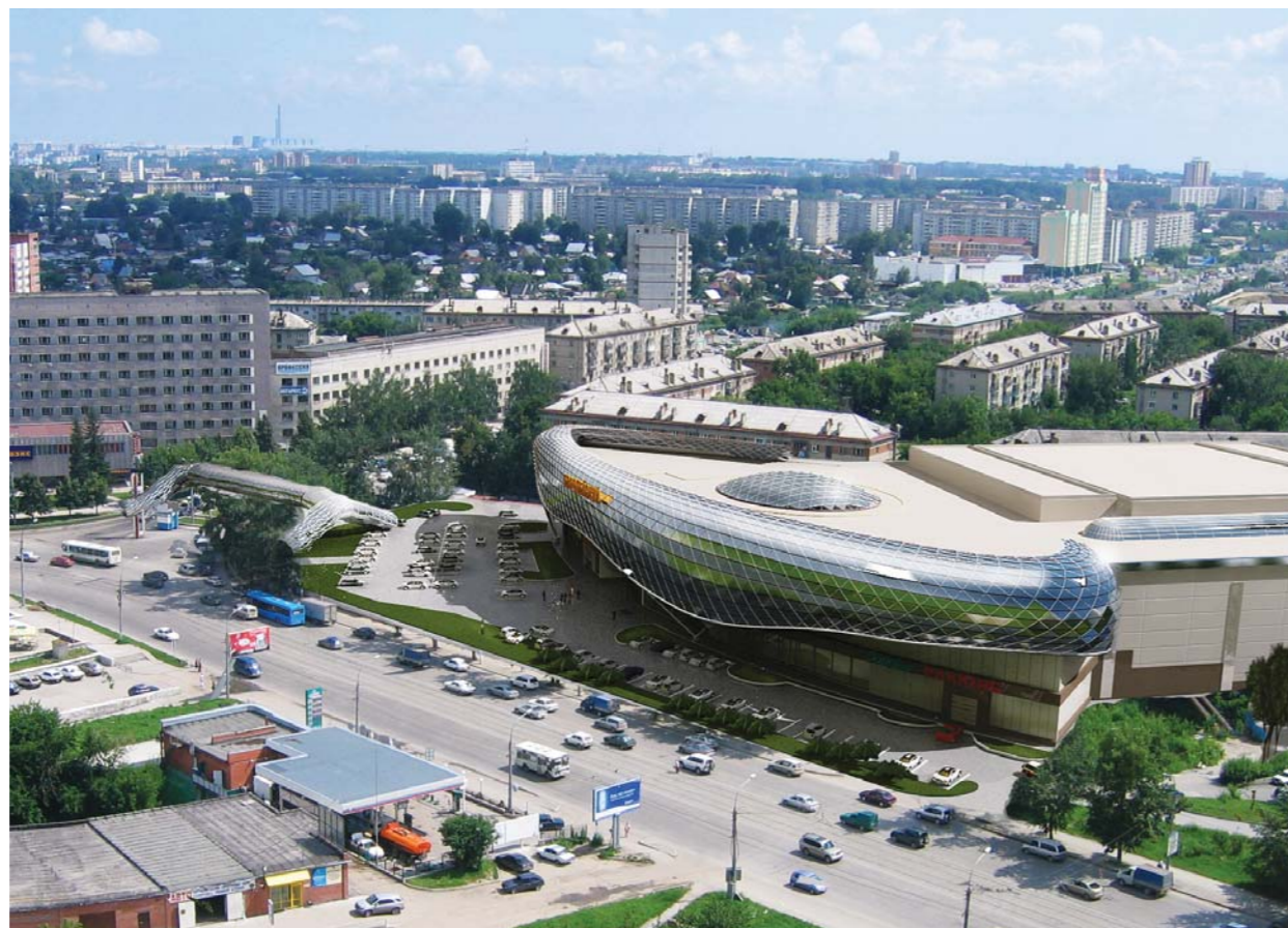
Культурно-развлекательный центр «ЕВРОПЕЙСКИЙ» , г. Новосибирск, ул. Танковая, д. 1, Калининский и Завельцовский р-ны. Проектирование-2010-2011. Строительство-2012 г.
