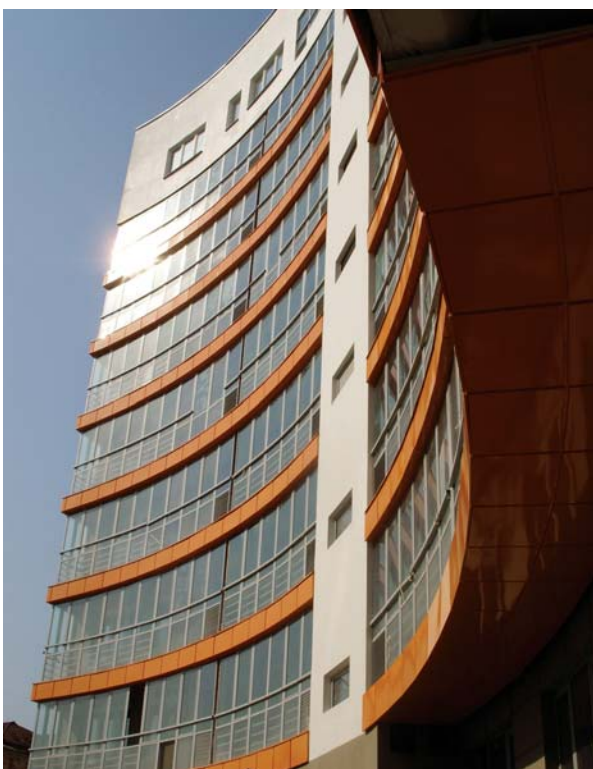
Жилой комплекс г. Москва, ул. Суворовская, д. 10-12. 2008 г. Руководитель авторского коллектива: В. Малай Архитекторы: М. Арсеньева, М. Новоселова Конструктор: В. Гусев
